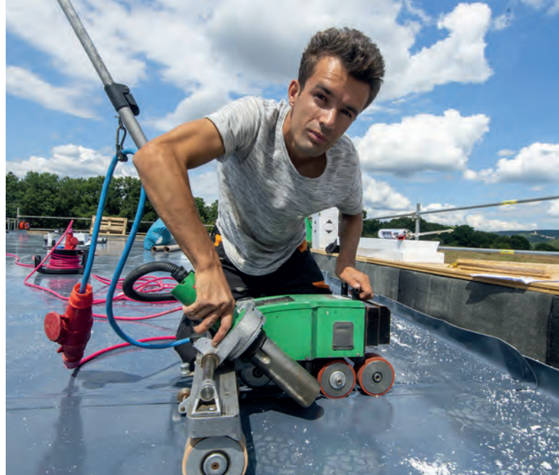
Dachdecker Geselle Safi Shujai
